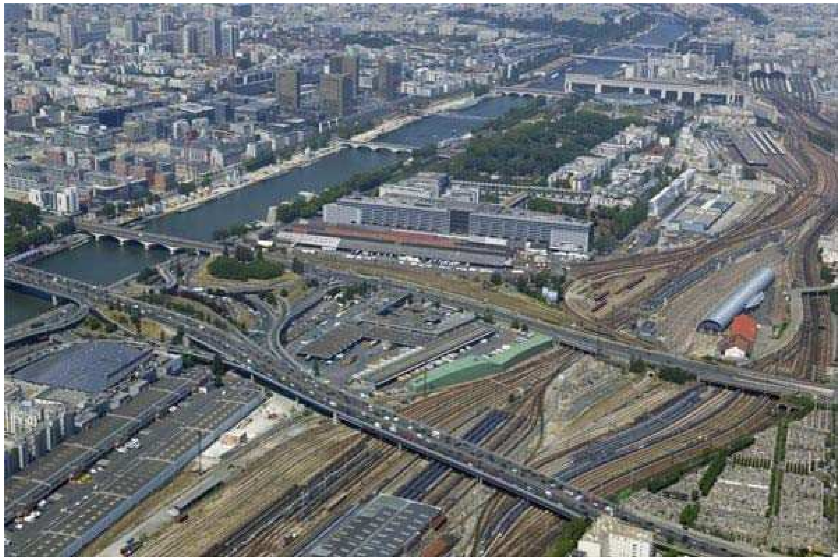
VUE AERIENNE DU SITE D'AMENAGEMENT DE LA RAPEE – PORTE DE BERCY / PARIS 12 e
