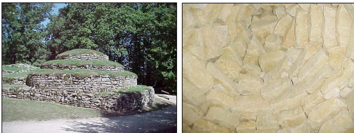
Figure 18. Bougon, Tumulus Fo, vues extérieure (à degrés) et intérieure (en encorbellement)
