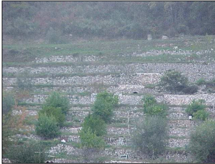
Figure 3. Murs de soutènement de cultures en terrasse à Nice (Alpes Maritimes)
