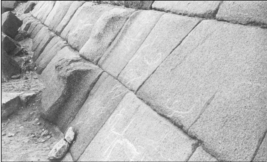
Figure 22. Revêtement final « ravalé » de la pyramide de Mykérinos
