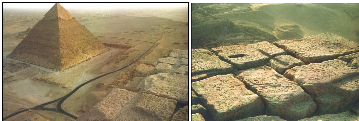
Figure 14. Entailles d'arasement des blocs du sommet de la pyramide de Khéops
