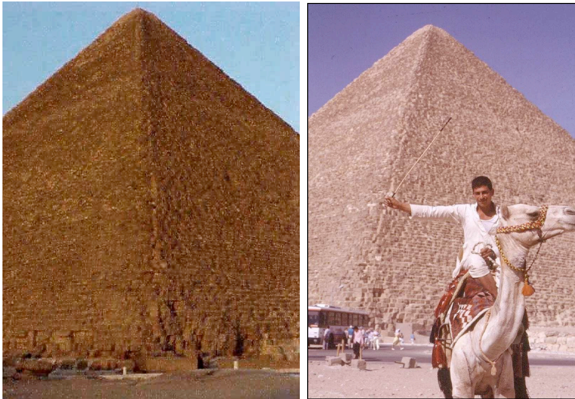
Figure 22. Arêtes S-E et S-O de la pyramide de Khéops : le « créneau formant escalier » est visible
