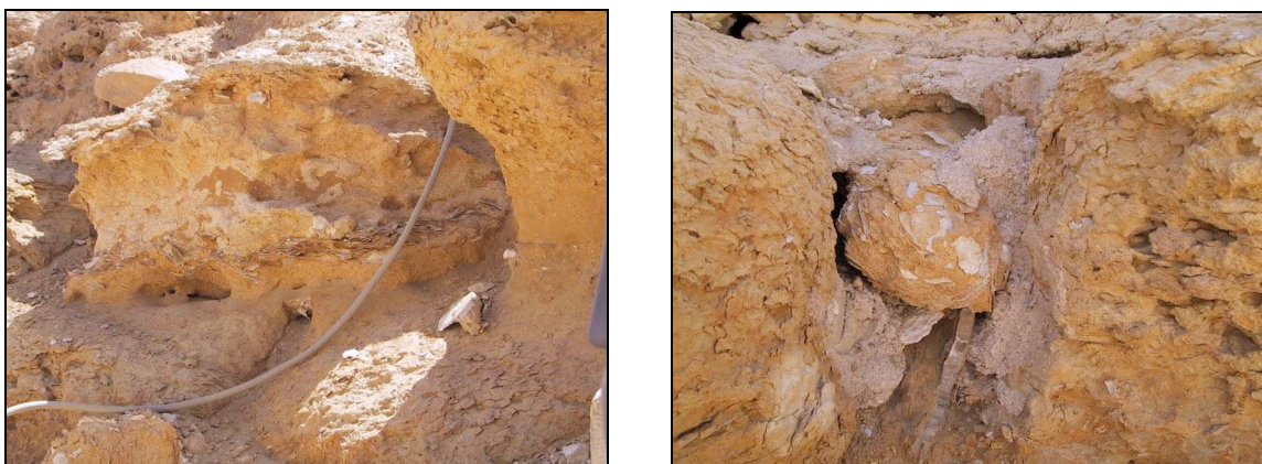
Figure 16. Matériaux constitutifs de la pyramide « rouge » : les bancs d'huîtres sont repérables
