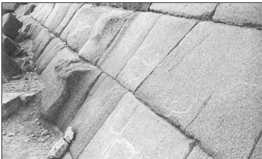
Figure 28. Ravèlement non terminé du revêtement final en granite de la pyramide de Mykérinos
