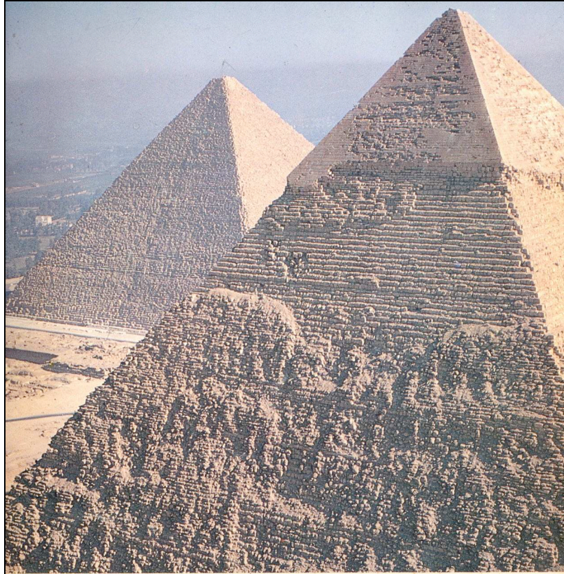
Figure 19. La partie érodée de la pyramide de Khephren nous montre bien des couches - enveloppes successives
