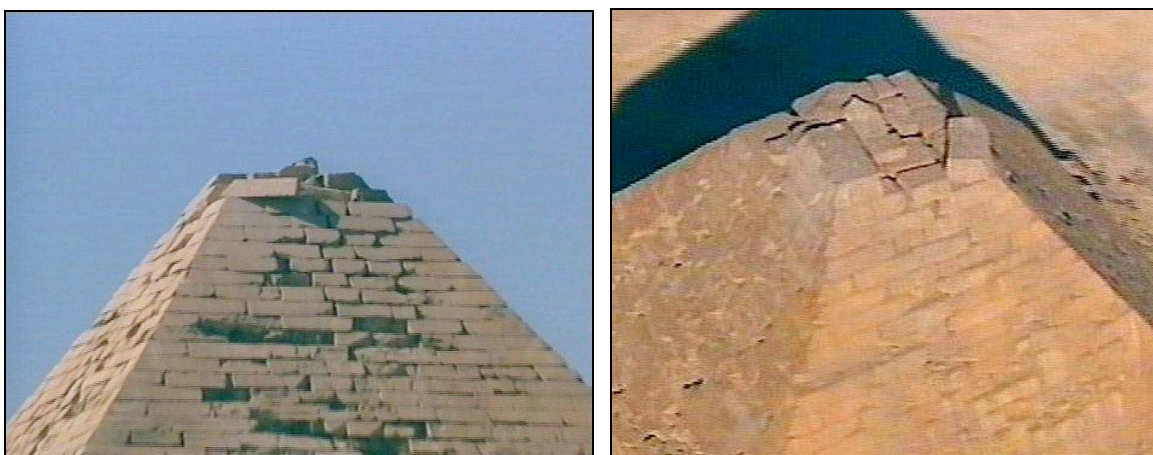
Figure 27. Le revêtement visible au sommet de la pyramide de Khephren poserait-il problème ?
