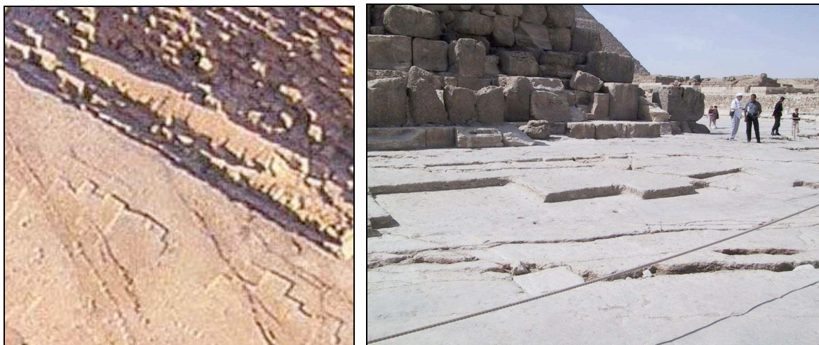
Figure 2. Les stigmates d'extraction sur le péribole de Kheops donnent la dimension des blocs.
