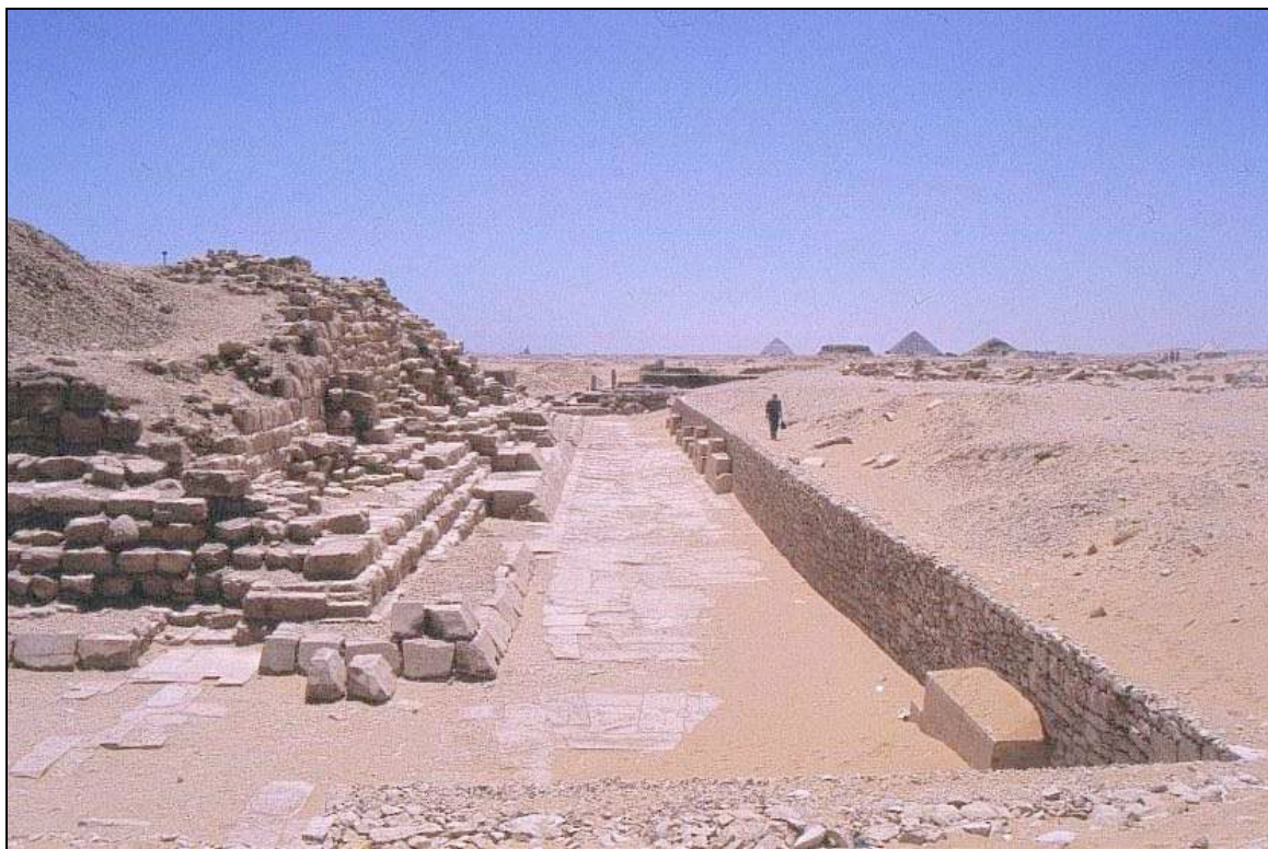
Figure 17. Pyramide de Pépi Ier, composée de parées concentriques, backing-stones et revêtement
