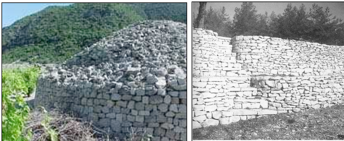
Figure 2. Murger de vignes et mur de soutènement de terrasse à degrés. Il faut monter sur le second pour pouvoir exhausser le premier, etc.
