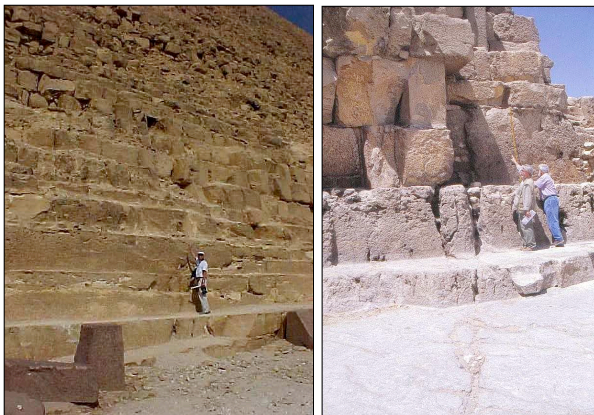
Figure 1. La fracturation naturelle se poursuit sur les premières assises des pyramides qui, donc, appartiennent à la roche mère du plateau (Khephren à gauche et Khéops à droite)
