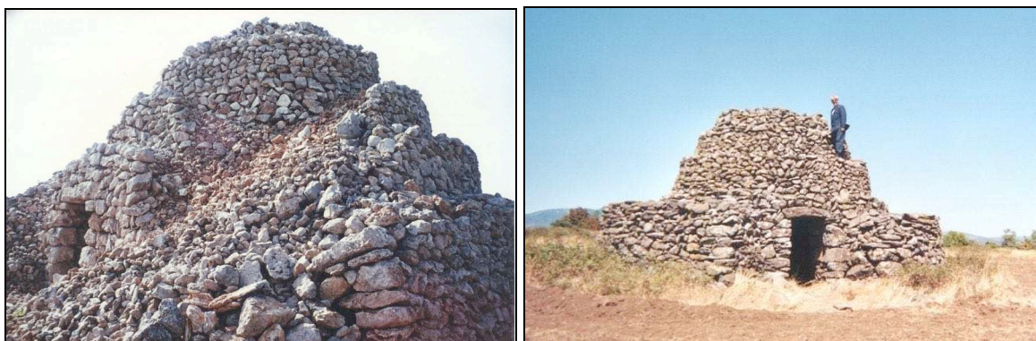
Figure 9. Parements intérieurs indépendants d'une Barracas et Capitelle du Salagou (Hérault)
